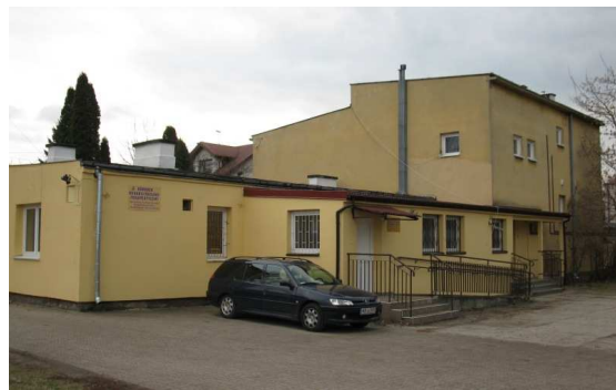
(widok od strony północno-wschodniej)
